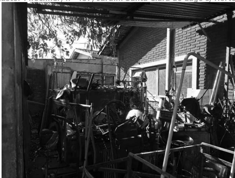
Imagem 17 – Vista Interna – GARAGEM. Imóvel verificado durante a DILIGÊNCIA / VISTORIA, pela PERÍCIA DO JUÍZO no local apontado nos autos. Muro em alvenaria / reboco / pintura. Cobertura leve de alumínio. Acesso franqueado pelo EXECUTADO.
