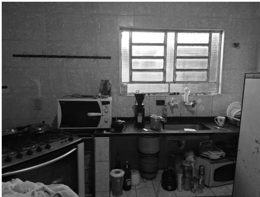
Imagem 42 – Vista Interna – CÔMODO 06 – COZINHA. Imóvel verificado durante a DILIGÊNCIA / VISTORIA, pela PERÍCIA DO JUÍZO no local apontado nos autos. Paredes em alvenaria / reboco / pintura. Piso e revestimento cerâmico. Esquadrias de alumínio. Acesso franqueado pelo EXECUTADO.
