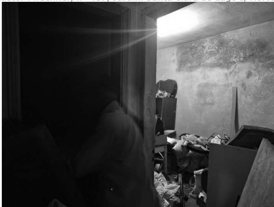
Imagem 47 – Vista Interna – CÔMODO 07. Imóvel verificado durante a DILIGÊNCIA / VISTORIA, pela PERÍCIA DO JUÍZO no local apontado nos autos. Paredes em alvenaria / reboco / pintura. Esquadrias de alumínio. Acesso franqueado pelo EXECUTADO.
