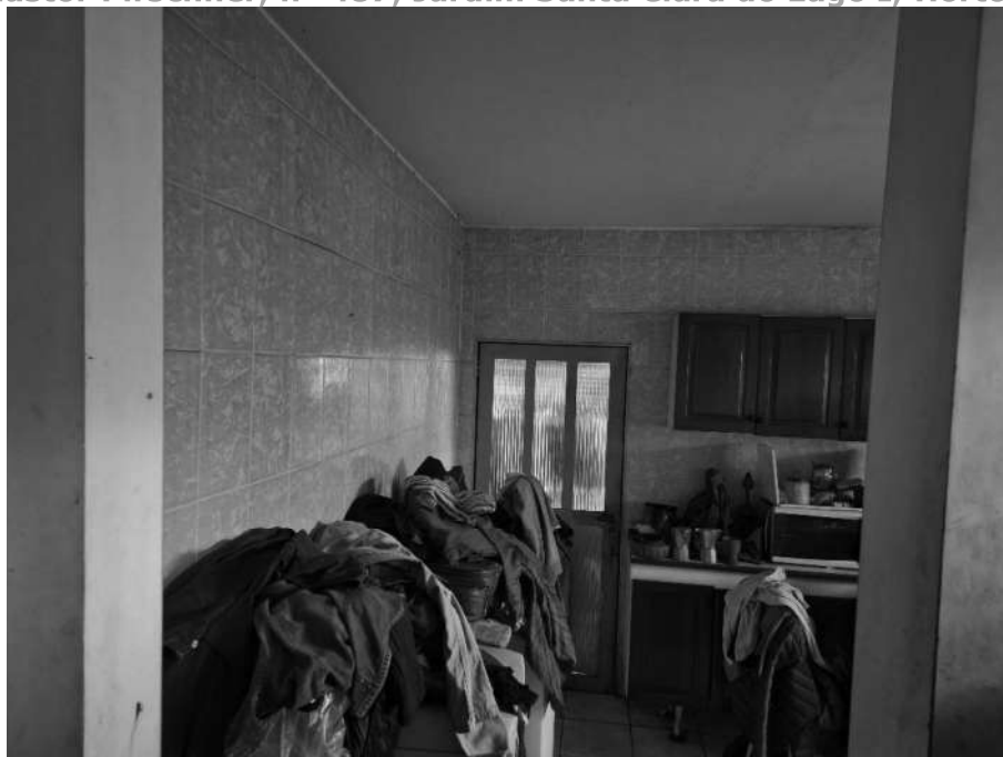
Imagem 39 – Vista Interna – CÔMODO 06 – COZINHA. Imóvel verificado durante a DILIGÊNCIA / VISTORIA, pela PERÍCIA DO JUÍZO no local apontado nos autos. Paredes em alvenaria / reboco / pintura. Piso e revestimento cerâmico. Esquadrias de alumínio. Acesso franqueado pelo EXECUTADO.
