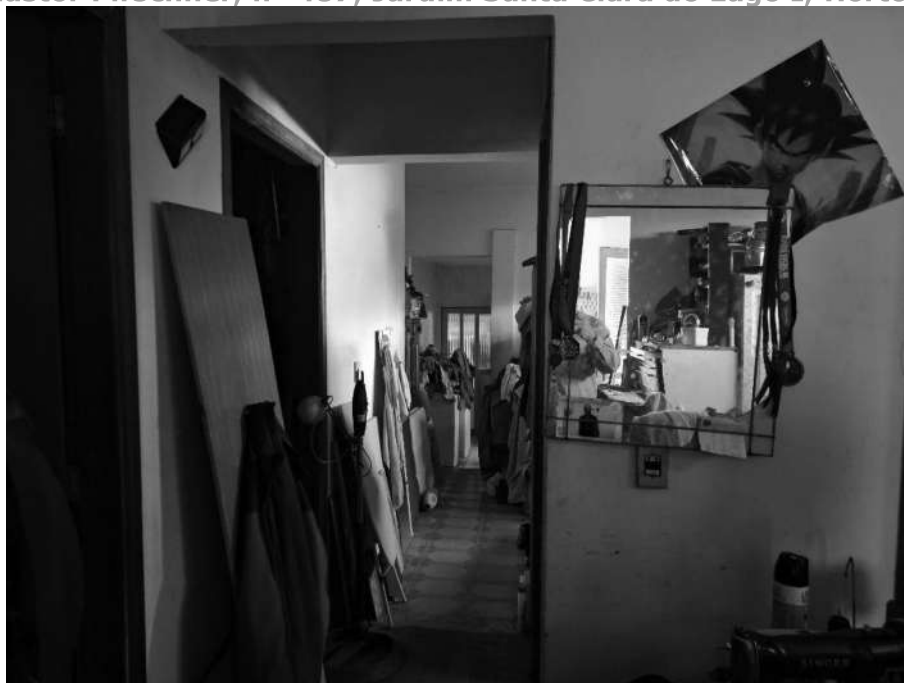
Imagem 25 – Vista Interna – ÁREA DE CIRCULAÇÃO. Imóvel verificado durante a DILIGÊNCIA / VISTORIA, pela PERÍCIA DO JUÍZO no local apontado nos autos. Paredes em alvenaria / reboco / pintura. Piso cerâmico. Acesso franqueado pelo EXECUTADO.
