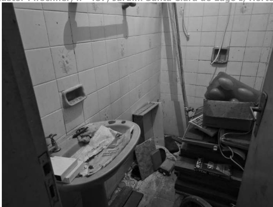
Imagem 49 – Vista Interna – BANHEIRO. Imóvel verificado durante a DILIGÊNCIA / VISTORIA, pela PERÍCIA DO JUÍZO no local apontado nos autos. Paredes em alvenaria / reboco / pintura. Piso e revestimento cerâmico. Acesso franqueado pelo EXECUTADO.
