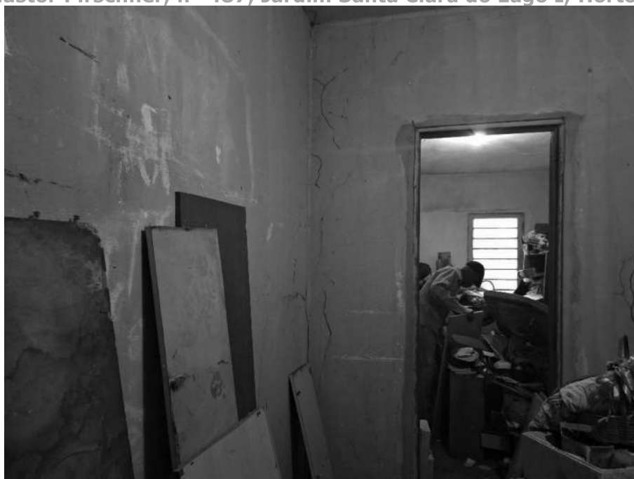
Imagem 55 – Vista Interna – CÔMODO 09. Imóvel verificado durante a DILIGÊNCIA / VISTORIA, pela PERÍCIA DO JUÍZO no local apontado nos autos. Paredes em alvenaria / reboco. Esquadrias de alumínio. Acesso franqueado pelo EXECUTADO.
