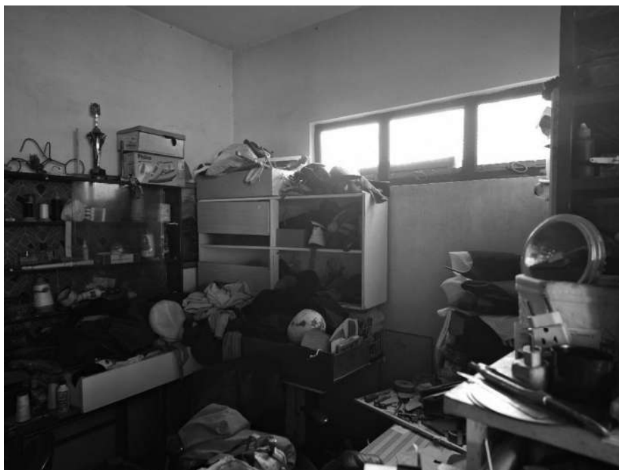
Imagem 24 – Vista Interna – CÔMODO 02. Imóvel verificado durante a DILIGÊNCIA / VISTORIA, pela PERÍCIA DO JUÍZO no local apontado nos autos. Paredes em alvenaria / reboco / pintura. Piso cerâmico. Acesso franqueado pelo EXECUTADO.
