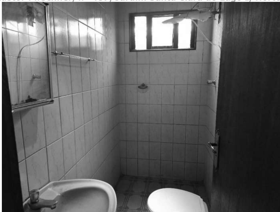
Imagem 31 – Vista Interna – BANHEIRO. Imóvel verificado durante a DILIGÊNCIA / VISTORIA, pela PERÍCIA DO JUÍZO no local apontado nos autos. Paredes em alvenaria / reboco / pintura. Piso e revestimento cerâmico. Acesso franqueado pelo EXECUTADO.
