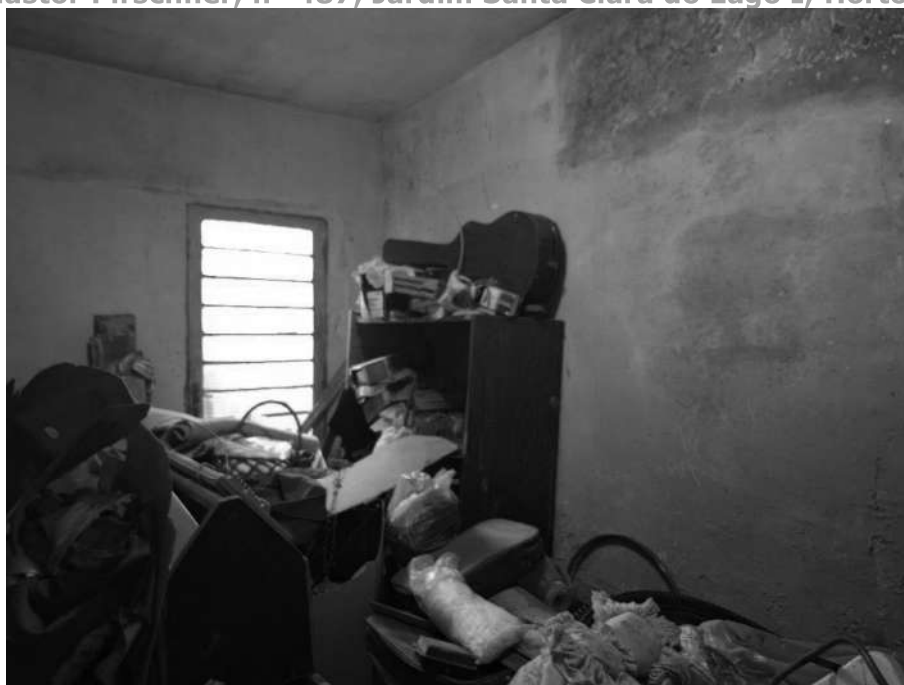
Imagem 51 – Vista Interna – CÔMODO 08. Imóvel verificado durante a DILIGÊNCIA / VISTORIA, pela PERÍCIA DO JUÍZO no local apontado nos autos. Paredes em alvenaria / reboco. Esquadrias de alumínio. Acesso franqueado pelo EXECUTADO.
