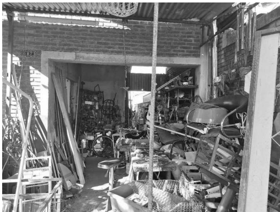
Imagem 18 – Vista Interna – GARAGEM. Imóvel verificado durante a DILIGÊNCIA / VISTORIA, pela PERÍCIA DO JUÍZO no local apontado nos autos. Paredes em alvenaria / reboco. Cobertura leve de alumínio. Acesso franqueado pelo EXECUTADO.
