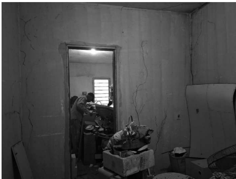
Imagem 54 – Vista Interna – CÔMODO 09. Imóvel verificado durante a DILIGÊNCIA / VISTORIA, pela PERÍCIA DO JUÍZO no local apontado nos autos. Paredes em alvenaria / reboco. Esquadrias de alumínio. Acesso franqueado pelo EXECUTADO.
