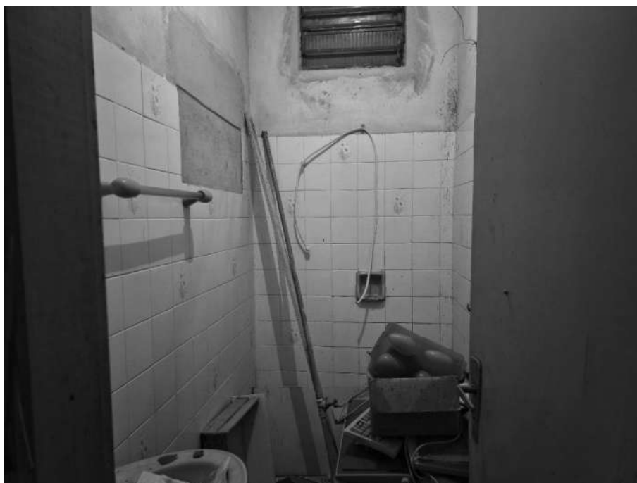
Imagem 48 – Vista Interna – BANHEIRO. Imóvel verificado durante a DILIGÊNCIA / VISTORIA, pela PERÍCIA DO JUÍZO no local apontado nos autos. Paredes em alvenaria / reboco / pintura. Piso e revestimento cerâmico. Acesso franqueado pelo EXECUTADO.
