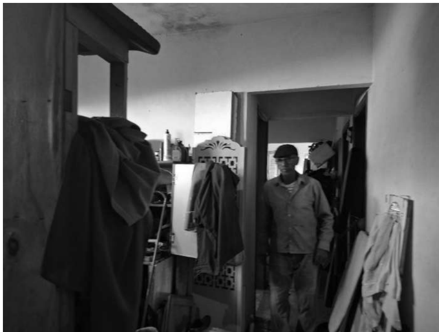
Imagem 38 – Vista Interna – CÔMODO 05. Imóvel verificado durante a DILIGÊNCIA / VISTORIA, pela PERÍCIA DO JUÍZO no local apontado nos autos. Paredes em alvenaria / reboco / pintura. Piso cerâmico. Acesso franqueado pelo EXECUTADO.
