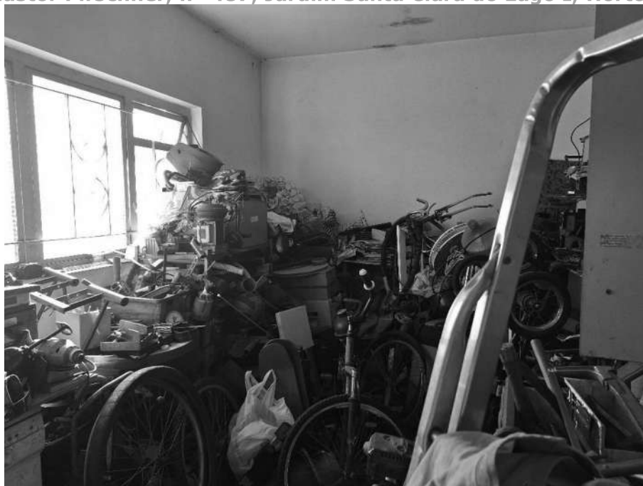
Imagem 21 – Vista Interna – CÔMODO 01 – SALA DE ESTAR. Imóvel verificado durante a DILIGÊNCIA / VISTORIA, pela PERÍCIA DO JUÍZO no local apontado nos autos. Paredes em alvenaria / reboco / pintura. Esquadrias de alumínio. Acesso franqueado pelo EXECUTADO.
