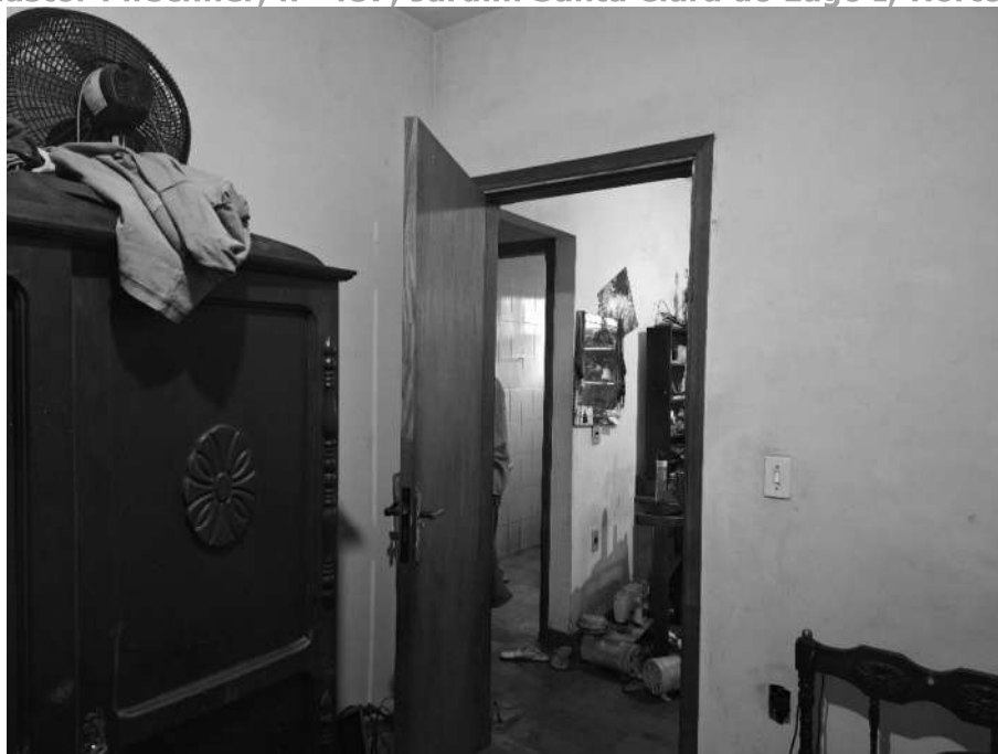
Imagem 29 – Vista Interna – CÔMODO 03 – DORMITÓRIO. Imóvel verificado durante a DILIGÊNCIA / VISTORIA, pela PERÍCIA DO JUÍZO no local apontado nos autos. Paredes em alvenaria / reboco / pintura. Piso cerâmico. Esquadrias de alumínio. Acesso franqueado pelo EXECUTADO.
