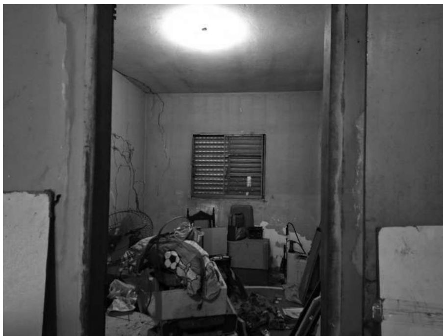
Imagem 52 – Vista Interna – CÔMODO 09. Imóvel verificado durante a DILIGÊNCIA / VISTORIA, pela PERÍCIA DO JUÍZO no local apontado nos autos. Paredes em alvenaria / reboco. Esquadrias de alumínio. Acesso franqueado pelo EXECUTADO.
