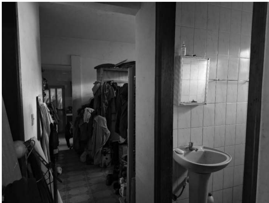
Imagem 30 – Vista Interna – ÁREA DE CIRCULAÇÃO. Imóvel verificado durante a DILIGÊNCIA / VISTORIA, pela PERÍCIA DO JUÍZO no local apontado nos autos. Paredes em alvenaria / reboco / pintura. Piso cerâmico. Acesso franqueado pelo EXECUTADO.
