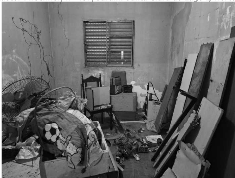
Imagem 53 – Vista Interna – CÔMODO 09. Imóvel verificado durante a DILIGÊNCIA / VISTORIA, pela PERÍCIA DO JUÍZO no local apontado nos autos. Paredes em alvenaria / reboco. Esquadrias de alumínio. Acesso franqueado pelo EXECUTADO.
