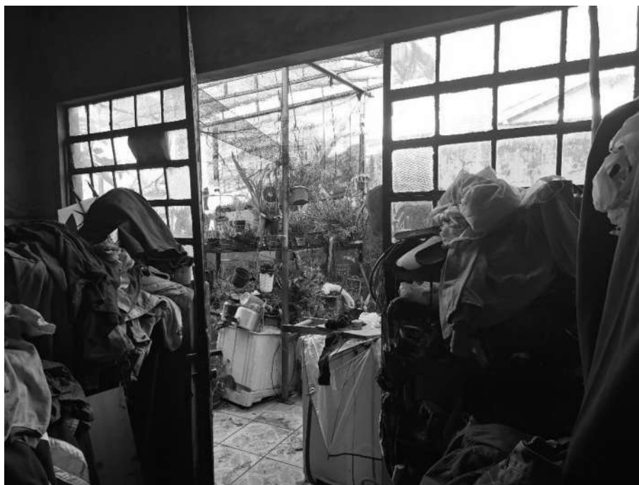
Imagem 58 – Vista Interna – CÔMODO 07 – Vista para Quintal. Imóvel verificado durante a DILIGÊNCIA / VISTORIA, pela PERÍCIA DO JUÍZO no local apontado nos autos. Paredes em alvenaria / reboco / pintura.
