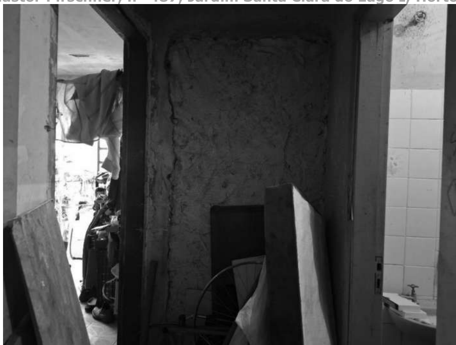
Imagem 57 – Vista Interna – ÁREA DE CIRCULAÇÃO. Imóvel verificado durante a DILIGÊNCIA / VISTORIA, pela PERÍCIA DO JUÍZO no local apontado nos autos. Paredes em alvenaria / reboco. Acesso franqueado pelo EXECUTADO.
