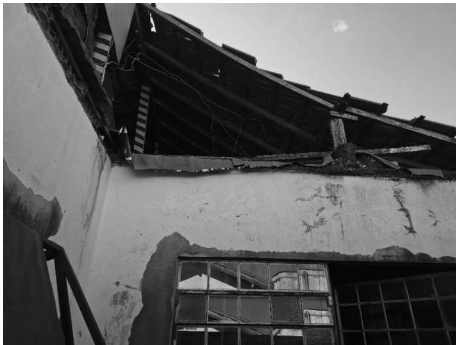
Imagem 68 – Vista Interna – QUINTAL – Vista para o telhado da residência. Imóvel verificado durante a DILIGÊNCIA / VISTORIA, pela PERÍCIA DO JUÍZO no local apontado nos autos. Muro em alvenaria / reboco. Acesso franqueado pelo EXECUTADO.
