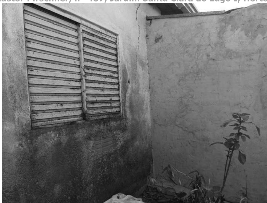
Imagem 63 – Vista Interna – QUINTAL. Imóvel verificado durante a DILIGÊNCIA / VISTORIA, pela PERÍCIA DO JUÍZO no local apontado nos autos. Muro em alvenaria / reboco. Acesso franqueado pelo EXECUTADO. Rua Adamastor Pirschner, nº 487, Jardim Santa Clara do Lago I, Hortolândia/SP.
