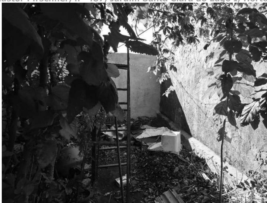
Imagem 61 – Vista Interna – QUINTAL. Imóvel verificado durante a DILIGÊNCIA / VISTORIA, pela PERÍCIA DO JUÍZO no local apontado nos autos. Muro em alvenaria / reboco. Acesso franqueado pelo EXECUTADO. Rua Adamastor Pirschner, nº 487, Jardim Santa Clara do Lago I, Hortolândia/SP.
