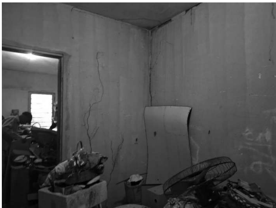
Imagem 56 – Vista Interna – CÔMODO 09. Imóvel verificado durante a DILIGÊNCIA / VISTORIA, pela PERÍCIA DO JUÍZO no local apontado nos autos. Paredes em alvenaria / reboco. Esquadrias de alumínio. Acesso franqueado pelo EXECUTADO.
