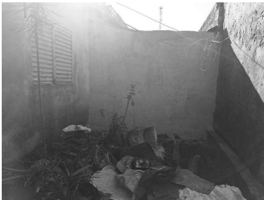
Imagem 62 – Vista Interna – QUINTAL. Imóvel verificado durante a DILIGÊNCIA / VISTORIA, pela PERÍCIA DO JUÍZO no local apontado nos autos. Muro em alvenaria / reboco. Acesso franqueado pelo EXECUTADO. Rua Adamastor Pirschner, nº 487, Jardim Santa Clara do Lago I, Hortolândia/SP.
