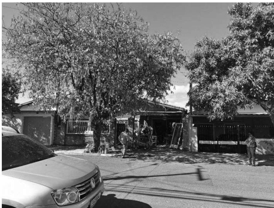
Imagem 74 – Vista Externa – FACHADA PRINCIPAL. Imóvel verificado durante a DILIGÊNCIA / VISTORIA, pela PERÍCIA DO JUÍZO no local apontado nos autos. Muro em alvenaria / reboco / pintura. Portão de ferro. Acesso franqueado pelo EXECUTADO.
