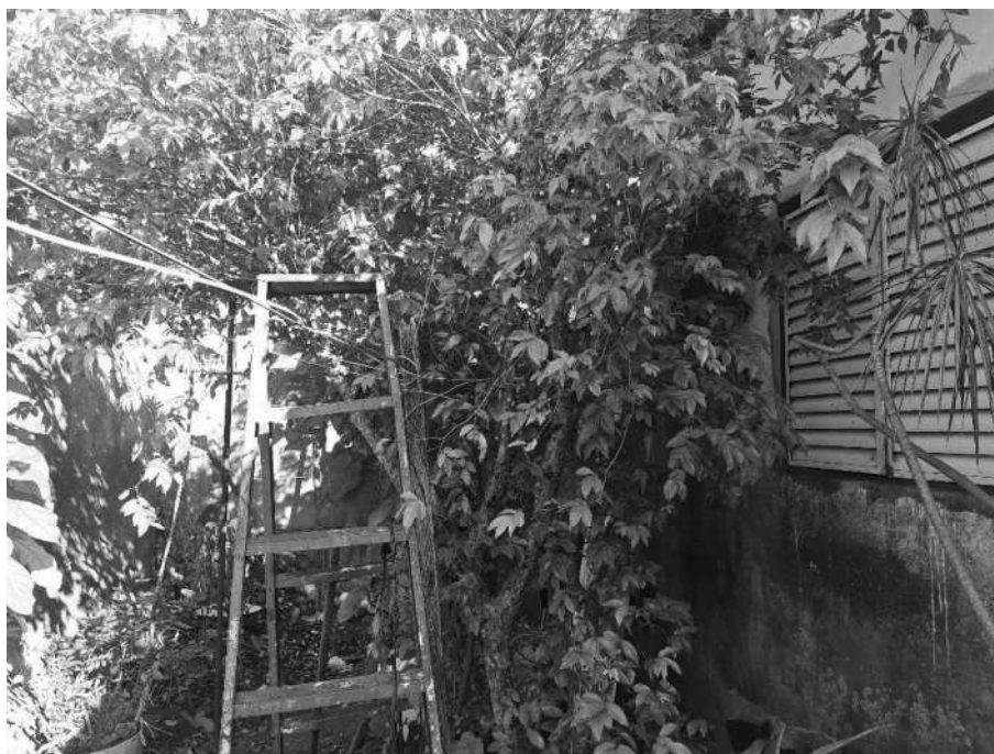
Imagem 64 – Vista Interna – QUINTAL. Imóvel verificado durante a DILIGÊNCIA / VISTORIA, pela PERÍCIA DO JUÍZO no local apontado nos autos. Muro em alvenaria / reboco. Acesso franqueado pelo EXECUTADO. Rua Adamastor Pirschner, nº 487, Jardim Santa Clara do Lago I, Hortolândia/SP.
