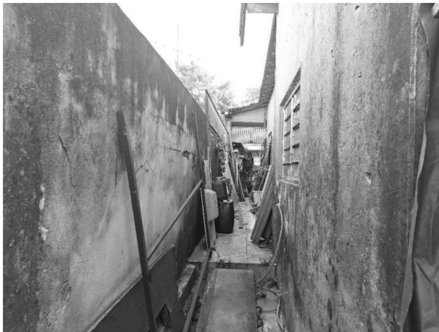
Imagem 66 – Vista Interna – CORREDOR. Imóvel verificado durante a DILIGÊNCIA / VISTORIA, pela PERÍCIA DO JUÍZO no local apontado nos autos. Muro em alvenaria / reboco. Piso cerâmico. Acesso franqueado pelo EXECUTADO.
