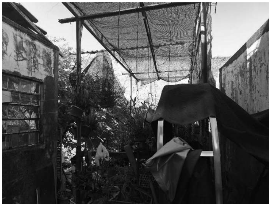
Imagem 70 – Vista Interna – QUINTAL. Imóvel verificado durante a DILIGÊNCIA / VISTORIA, pela PERÍCIA DO JUÍZO no local apontado nos autos. Muro em alvenaria / reboco. Acesso franqueado pelo EXECUTADO. Rua Adamastor Pirschner, nº 487, Jardim Santa Clara do Lago I, Hortolândia/SP.
