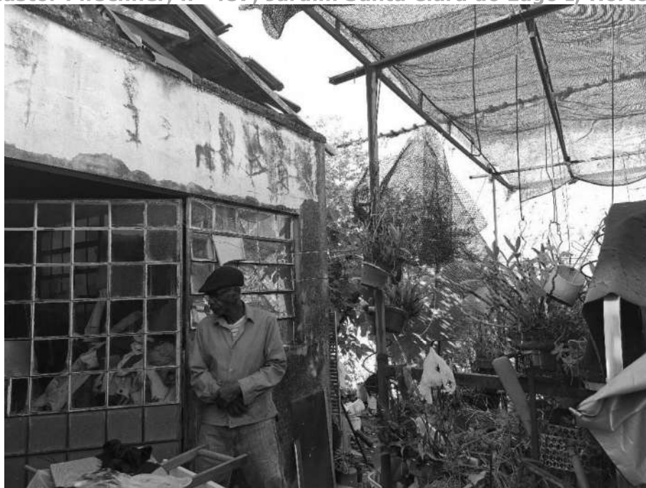
Imagem 69 – Vista Interna – QUINTAL. Imóvel verificado durante a DILIGÊNCIA / VISTORIA, pela PERÍCIA DO JUÍZO no local apontado nos autos. Muro em alvenaria / reboco. Acesso franqueado pelo EXECUTADO.
