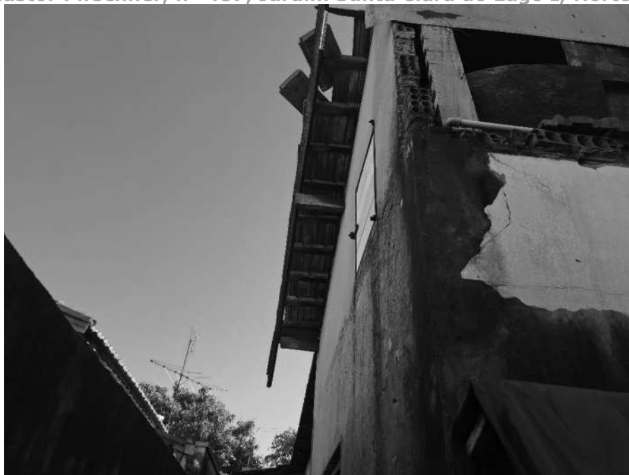
Imagem 67 – Vista Interna – QUINTAL – Vista para o telhado da residência. Imóvel verificado durante a DILIGÊNCIA / VISTORIA, pela PERÍCIA DO JUÍZO no local apontado nos autos. Muro em alvenaria / reboco. Acesso franqueado pelo EXECUTADO.
